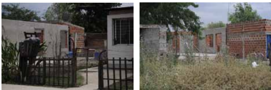
Figura 2. Viviendas en construcción y construcciones previas anexas a las mismas
